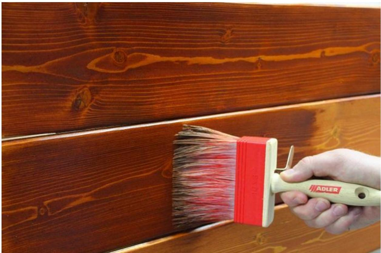
Сушка второго слоя Pullex 3in1-Lasur 12 часов при температуре 20°C. Высокая влажность и /или низкие температуры замедляют процесс высыхания и увеличивают время сушки.
